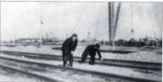
47 Während die Bahnanlagen noch im Bau sind, wird bereits ausgebildet. Hier demonstrieren (angehende?) Rangierer wie Bremschuhe aufgelegt werden
