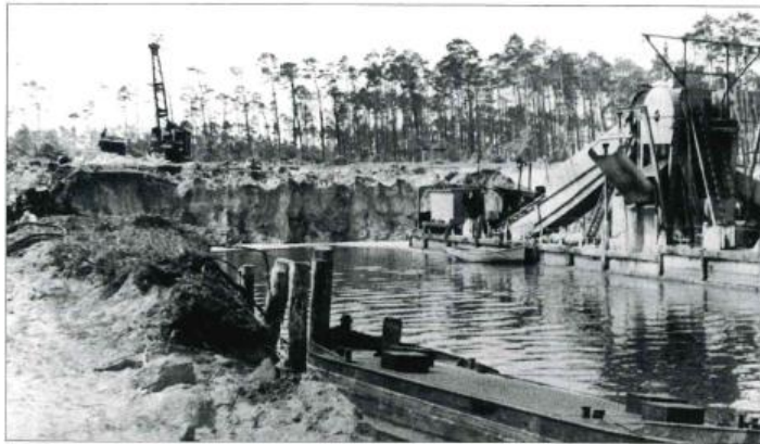
7 Baggerung des Hafenbeckens B durch den Schwimmbagger „Warnemünde“ 1958
