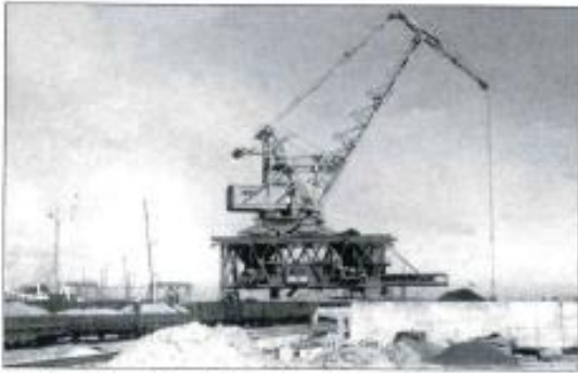
45 Die Bahngleise führen bereits zu den bestehenden und noch im Bau befindlichen Umschlaganlagen.
