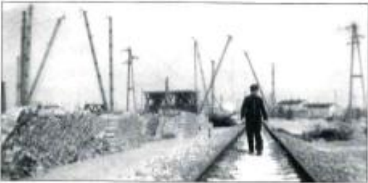
46 Neben dem Gleis werden Baustoffe gelagert; im Hintergrund verkünden die aufgerichteten Derrick-Kräne rege Bautätigkeit.
