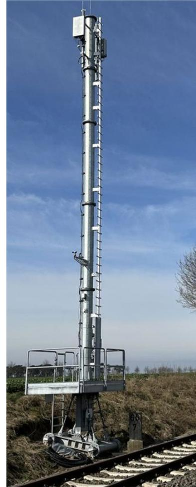
1) 15m Stahlrohrmast im Vergleich zu einem konventionellen 30m Stahlgittermast
