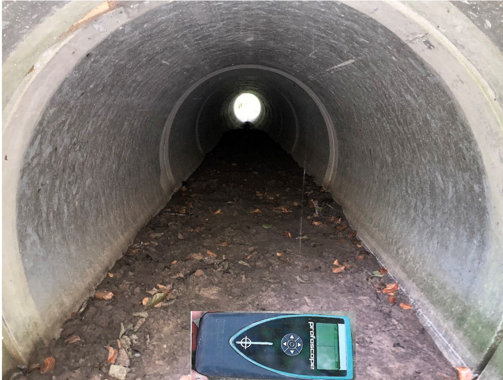
Erkundung Bewehrung mit Bewehrungssuchgerät und punktuelles Freilegen
