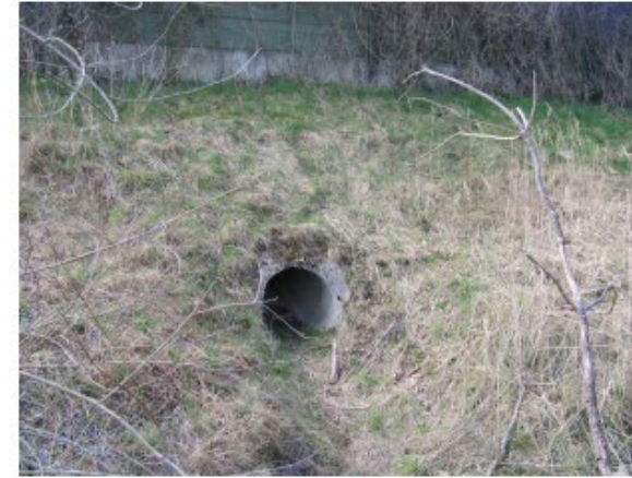
Abbildung 1: Stirnbauwerk des Durchlasses.
