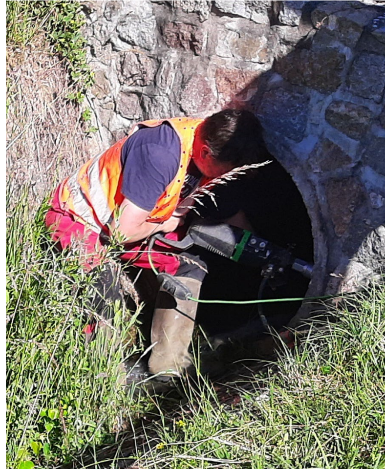
Kernbohrung im Betonrohr → für Probenahme Betonzylinder zur Ermittlung Druckfestigkeit
