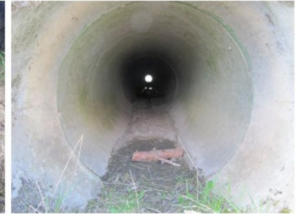
Abbildung 2: Blick in den Durchlass.
