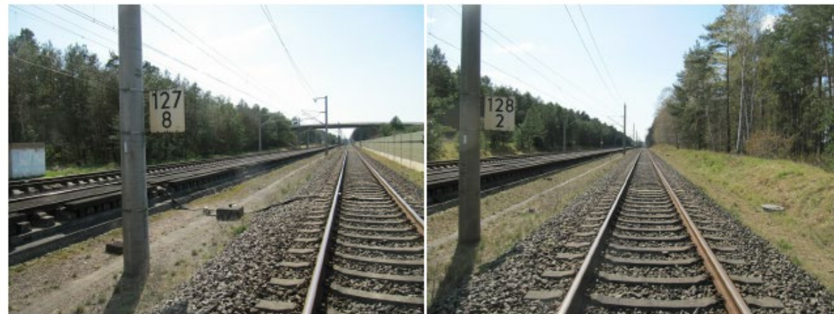
Abbildung 1: Blick auf das Erdbauwerk. Links: km 127,800, Rechts: km 128,300
